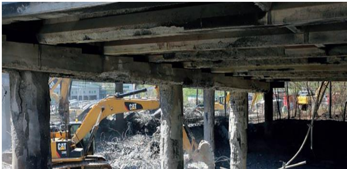
Рис. 1. Обрушение секции автомобильной эстакады
