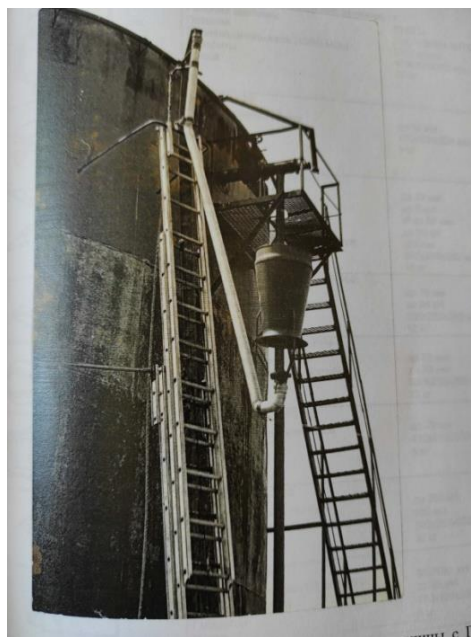
Рис. 8. Модуль телескопической мачты для вырезания отверстия и подачи пены
