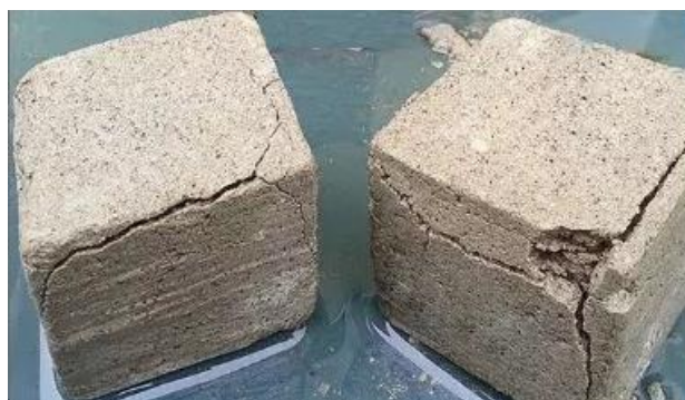
Рис. 4. Раннее разрушение бетона до проведения испытаний на сжатие
